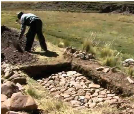
Figura 48: Nivelación del piso para la construcción de un baño seco
