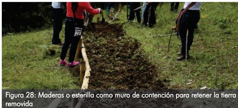
Figura 28: Maderas o esterilla como muro de contención para retener la tierra removida
