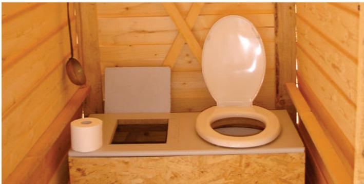
Figura 46: Construcción de un baño seco con madera pulida.
