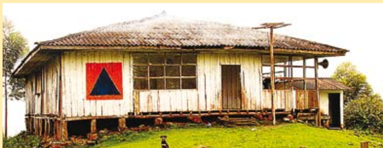
Foto Archivo Resguardo Kwet Wala. Antigua Casa Materna, comunidad La Fría. Fue derribada para reconstruirla y adecuarla mejor como S.A.P.
