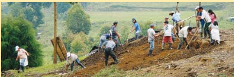
Foto Archivo Resguardo Kwet Wala. Trabajo comunitario. Construcción de la nueva Casa Materna.
