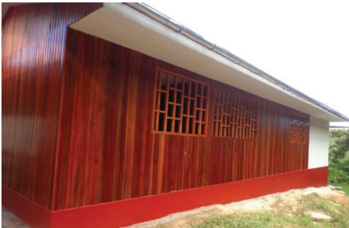
Foto: Registro Fotográfico Propio
