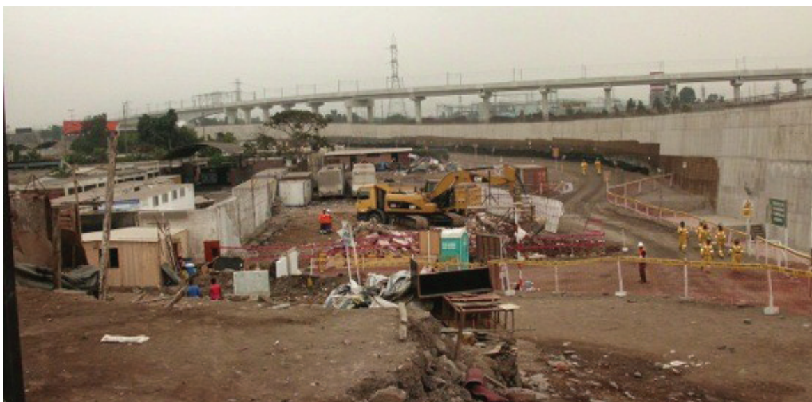
Foto: Obras del proyecto Vía Parque Rímac en Cantagallo
