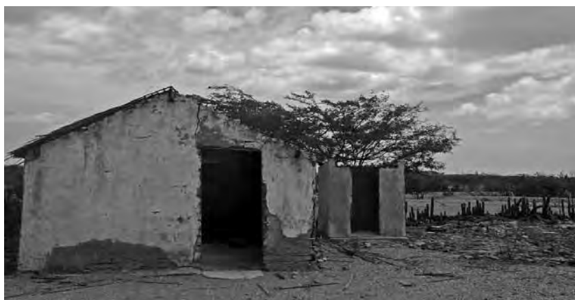
Instalaciones de la escuela y viviendas destruidas, Bahía Portete, MH, abril de 2010
