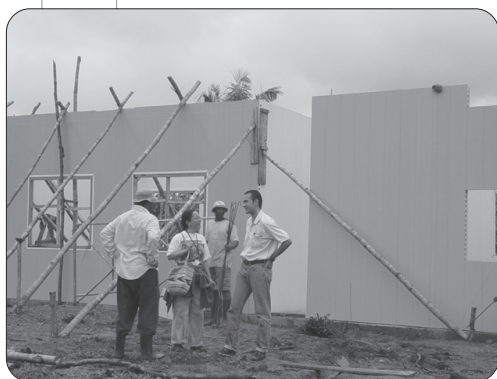
Construcción de la escuela El Reposo II, Quibdó, Chocó.
