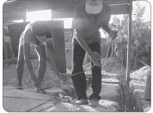
Armando estructuras de la casa 3, sector El Palmar Sur, OFP, Santander.
