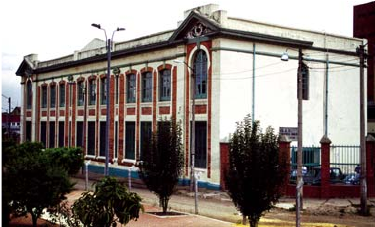
Edificio del Centro Educativo Distrital Santa Inés Bogotá, D.C.
