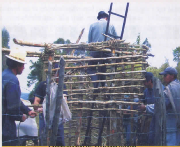
Construcción de vivienda propia Comunidad de Tulpud (Muellamues)
