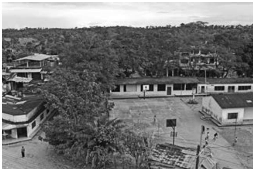
Edificio segundo plano y escuela primer plano
